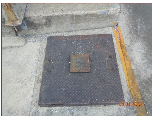
ภาพที่ 2.3-17 บ่อดักน้ำฝนปนเปื้อน ขนาด 400 ลิตร
