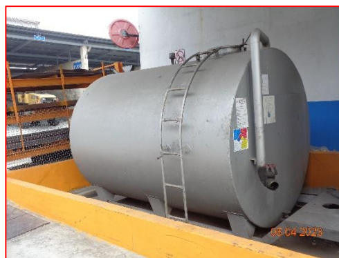
ภาพที่ 2.3-22 กำแพงล้อมรอบถังเก็บกัก น้ำมันดีเซล
