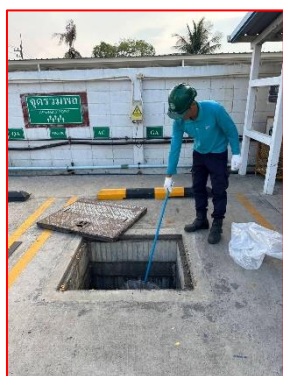
ภาพที่ 2.3-15 พนักงานทำความสะอาด บ่อดักน้ำมันและอลูมิเนียม (Oil & Sand Trap)
