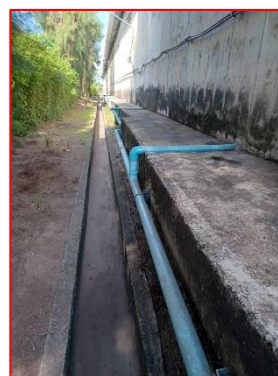
ภาพที่ 2.3-18 ท่อรวบรวมน้ำฝนปนเปื้อน บริเวณลานเก็บกองวัตถุดิบ
