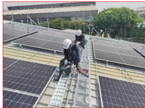
ภาพที่ 2.3-15 ขณะติดตั้งแผงเซลล์แสงอาทิตย์
