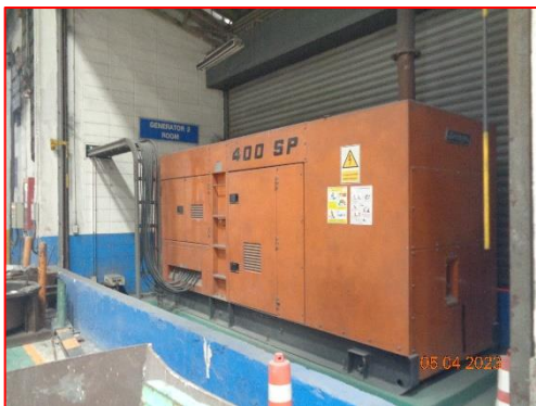
ภาพที่ 2.3-3 เครื่องกำเนิดไฟฟ้าสำรอง
